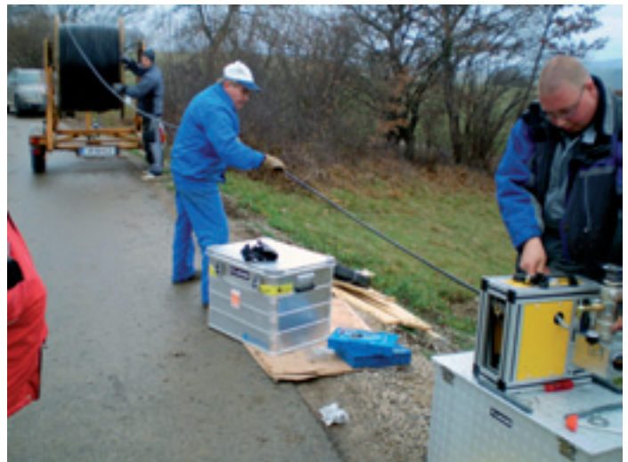
Upuhivanje svjetlovodnog kablova sljedeći je korak nakon polaganja alkatene cijevi u mikrorov (trench)
