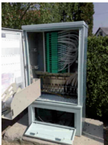
Ulični ormarić (kabinet) u koji može biti smješten distribucijski čvor svjetlovodne distribucijske mreže, a koji regulativa prostornog uređenja i gradnje nužno mora prihvatiti kao prostorni element
